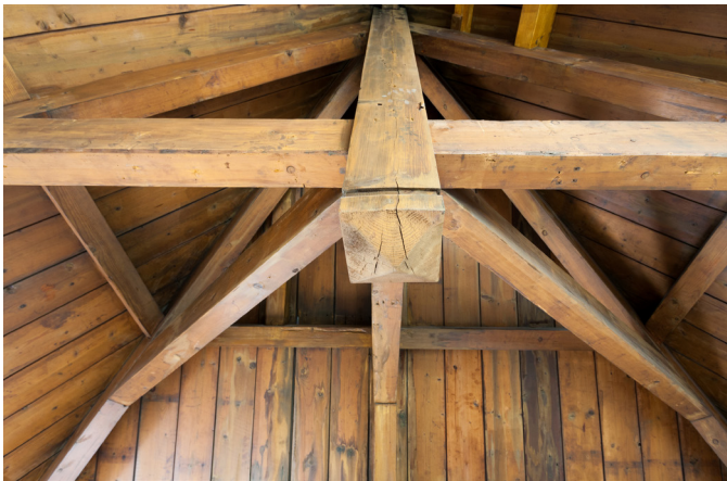
foto's interieur (zolder & trappenhuis)
